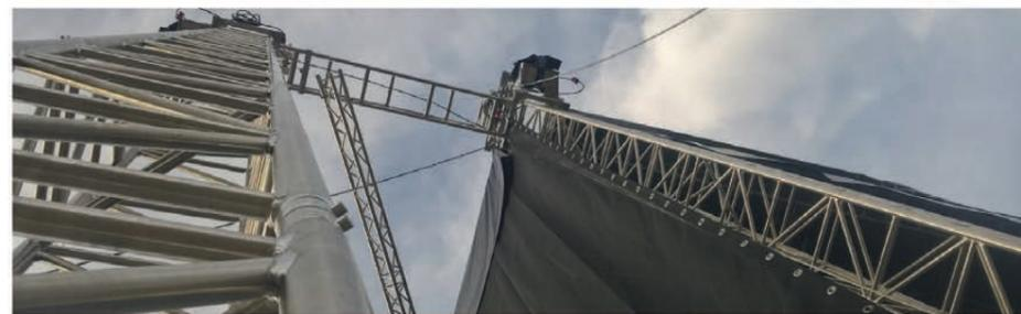
специальной техники. Сценический комплекс состоит из тентовой конструкции, построенной на базе элементов из алюминиевого сплава, подиумной конструкции из стали и двух дополнительных порталов под линейный акустический массив. Все элементы комплекса – легкие и мобильные, что обеспечивает удобство транспортировки. Тентовая конструкция
