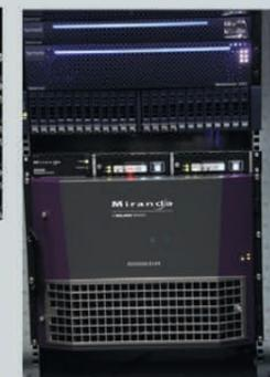
Основой трактообразующего оборудования являются два модульных матричных коммутатора Grass Valley NVISION 8144 под управлением системы NV920D.
