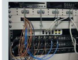
Система распределения сигналов Riedel Mediomet обеспечивает в реальном времени обработку и преобразование
