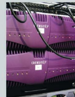
Для формирования эфирных выходных трактов используется коммутационно-распределительное оборудование на базе Grass Valley Densite 3.
