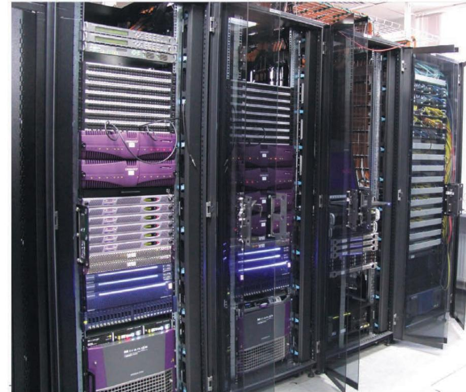
ВСЕ ТЕХНОЛОГИЧЕСКОЕ ОБОРУДОВАНИЕ УСТАНОВЛИВАЕТСЯ В НЕСКОЛЬКО СТОЕЧНЫХ ШКАФОВ, ЧТО ПОЗВОЛЯЕТ ИСПОЛЬЗОВАТЬ СУЩЕСТВУЮЩИЙ МАШИННЫЙ ЗАЛ
