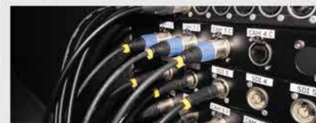
Все кабельные линии, соединяющие аппаратную и съёмочную зону, заложены стационарно, с терминированием на панели подключений в студии.
