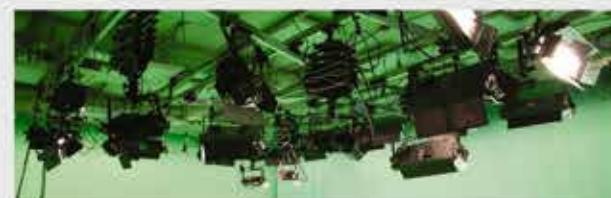
Система спецосвещения дает возможность создания всех элементов художественного света: контрового, фонового, рисующего и заполняющего.
