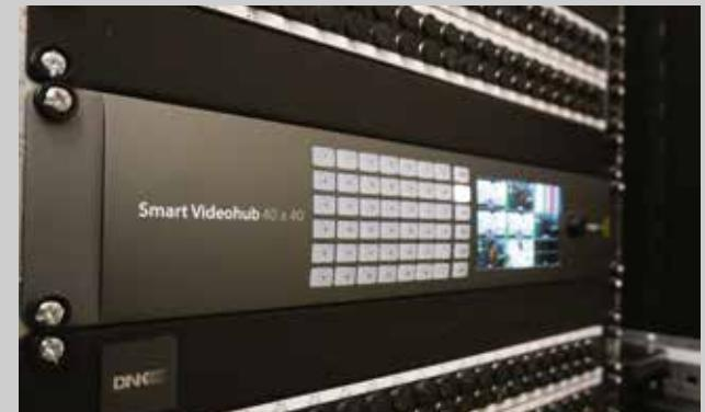
Коммутационным ядром видеотракта является Videohub 40x40, подключенный к оборудованию как АСБ, так и эфирного комплекса. Однако авария коммутатора не влияет ни на непрерывность вещания, ни на подключение камер и плееров к видеомикшеру ATEM 2 M/E. В то же время, микшер резервирован самим матричным коммутатором.
