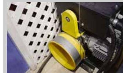
Для раздвижных занавесов смонтирована тросовая система с напольными электролебёдками барабанного типа.
