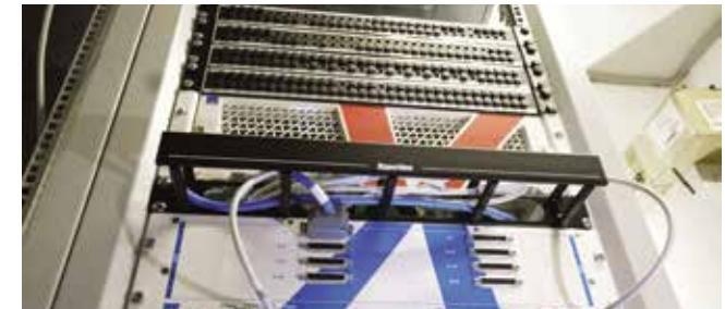
управления на рабочих местах. Интегрированы системы преобразования, мониторинга и инструментального контроля видео- и аудиосигналов. Проложена магистральная волоконно-оптическая и коаксиальная сеть обмена между потребителями/ источниками и центральной матрицей. Благодаря системе оркестрации и управления, которая одинаково хорошо работает как в классических системах SDI, так в новых IP-системах, обеспечен «бесшовный» перевод производства ТВЦ из среды SDI в IP. Применённые
