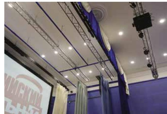
две системы раздвижных занавесов - антрактная и перед экраном. Управление возможно как с основного шкафа, так и с выносных, в противоположной стороне сцены. Система тросовая, с напольными электролебёдками барабанного типа. Для
