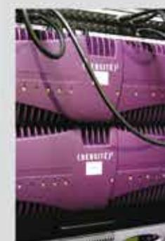
Для формирования эфирных выходных трактов используется коммутационно-распределительное оборудование на базе Grass Valley Densite 3.
